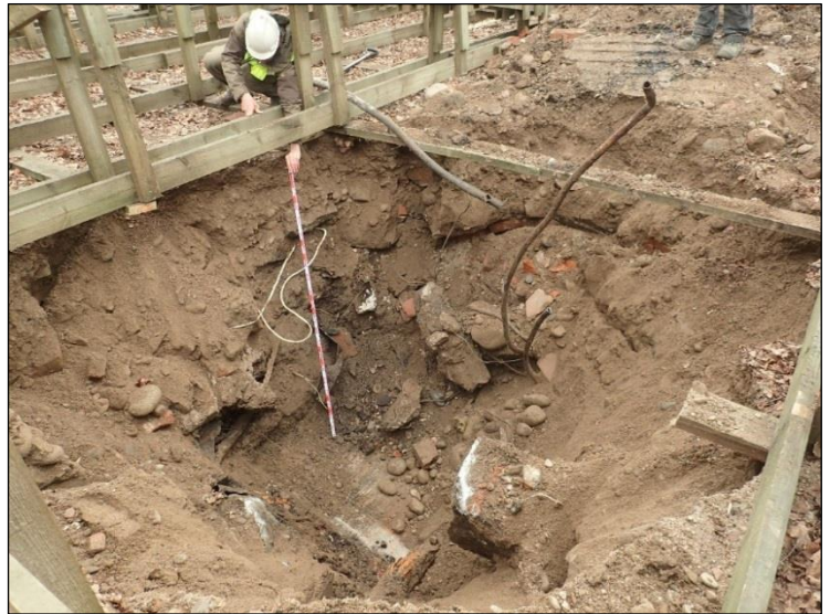
Kuva: Kaivausalue 18 loppuun kaivettuna. Pohjalla erottuu teräsbetonilaatta. Mitan pituus 2 m. Lounaasta.
