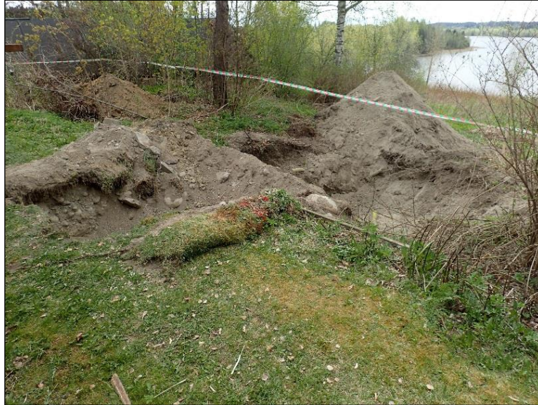
Kuva: Kaivausalueet 4 (vasemmalla) ja 5. Luoteesta.
